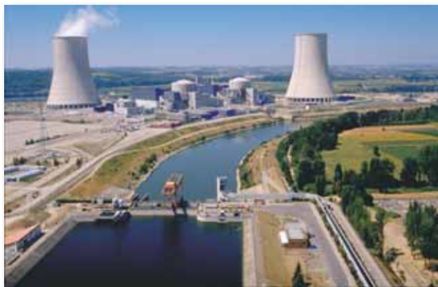
Centrale nucléaire de Golfech
