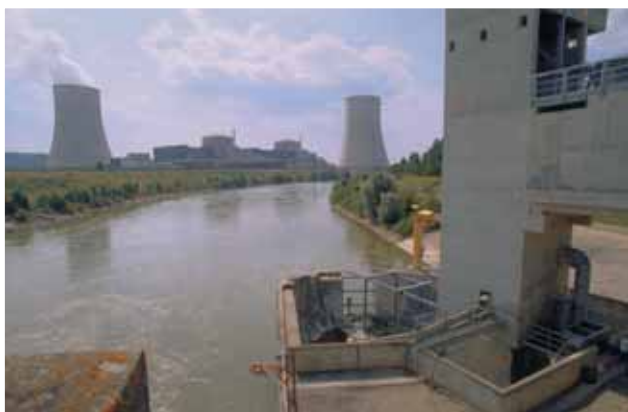
Ascenseur à poissons
